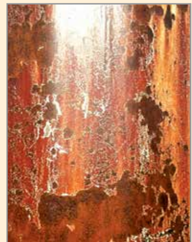
شکل (۷) تصویر یکی از الکترودها که دچار پدیده خوردگی موضعی شده است.
