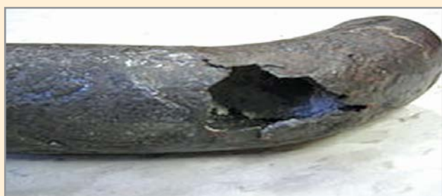
شکل (۱۵) ایجاد پدیده شکست و اکسیداسیون در لوله های دیگ بخار
