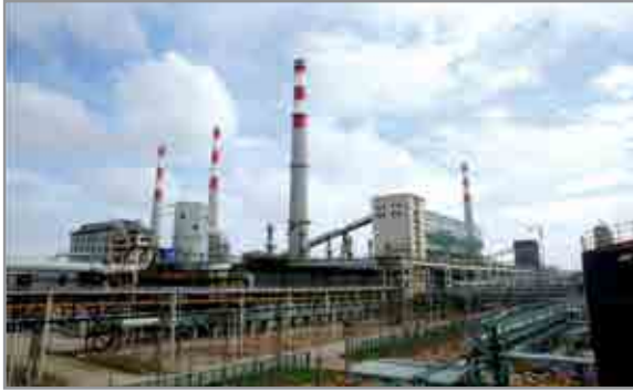
تصویر ۱- باطری کک سازی به روش بازیافت شیمیایی با ارتفاع سلول ۷ متر در بانو اسیل چین
