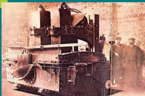
تصویر-۱: اولین (چپ) هرولت (۱۹۰۶) و بزرگترین (راست) کوره قوس الکتریکی جهان
