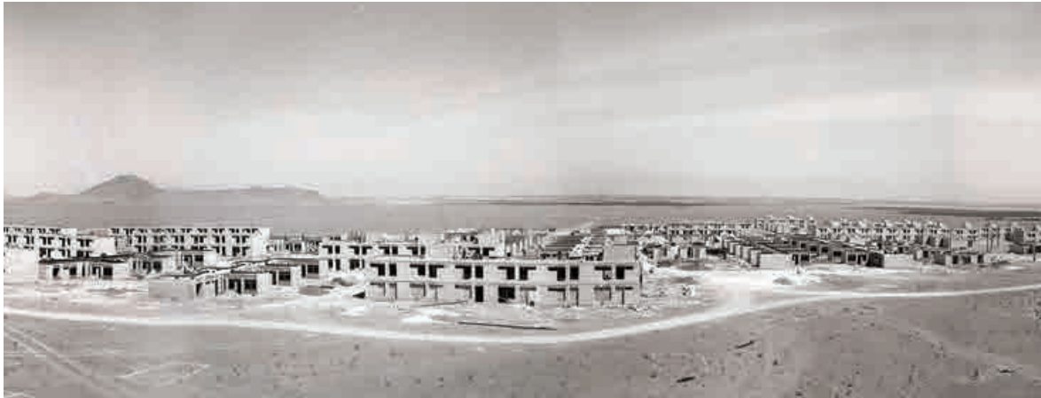
▲ سال ۱۳۴۹ * نمایی از پولادشهر در حال ساخت
