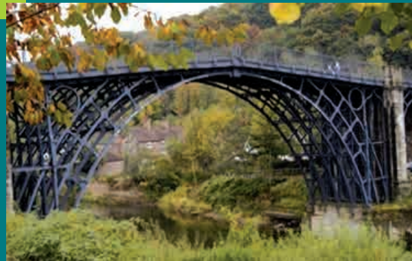
تصویر-۵: پل آهنی Shropshire انگلستان به وزن ۳۲۹ تن ساخته شده از چدن (سال ۱۷۸۱)
