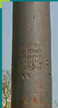
تصویر-۷: سر ستون آهنی دهلی‌نو، ۱۶۲۱ سال مقاومت در برابر خوردگی (قطر ۴۱ سانتیمتر، طول ۷/۲۱ متر)
