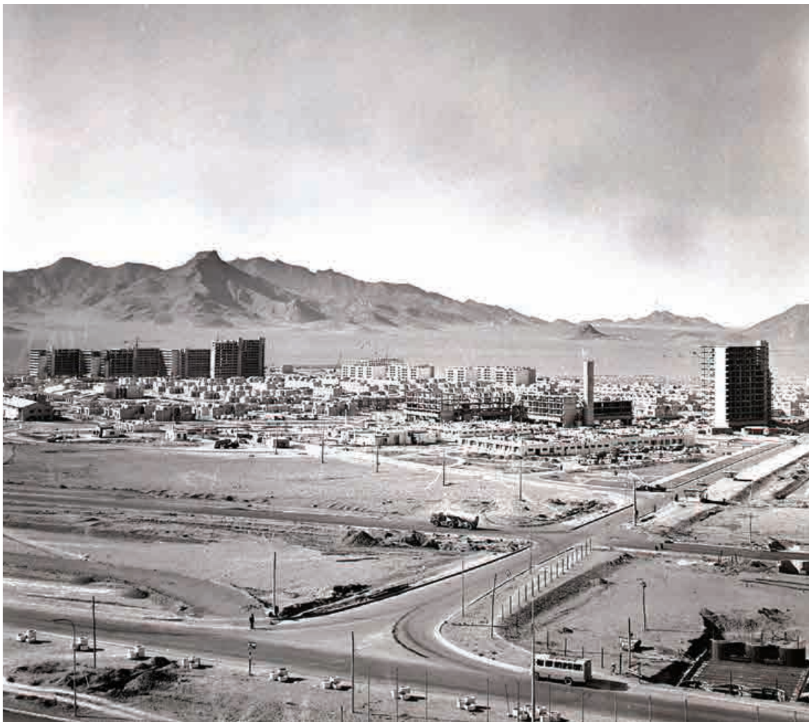
▲ سال ۱۳۴۹ * نمایی از پولادشهر در حال ساخت
