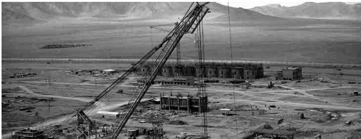
▲ سال ۱۳۴۸ * نمایی از ساخت سیلوهای کک سازی
