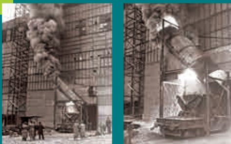
تصویر-۳: اولین آزمایشات و تولید فولاد به روش دمش اکسیژن در شهر لینز اتریش
